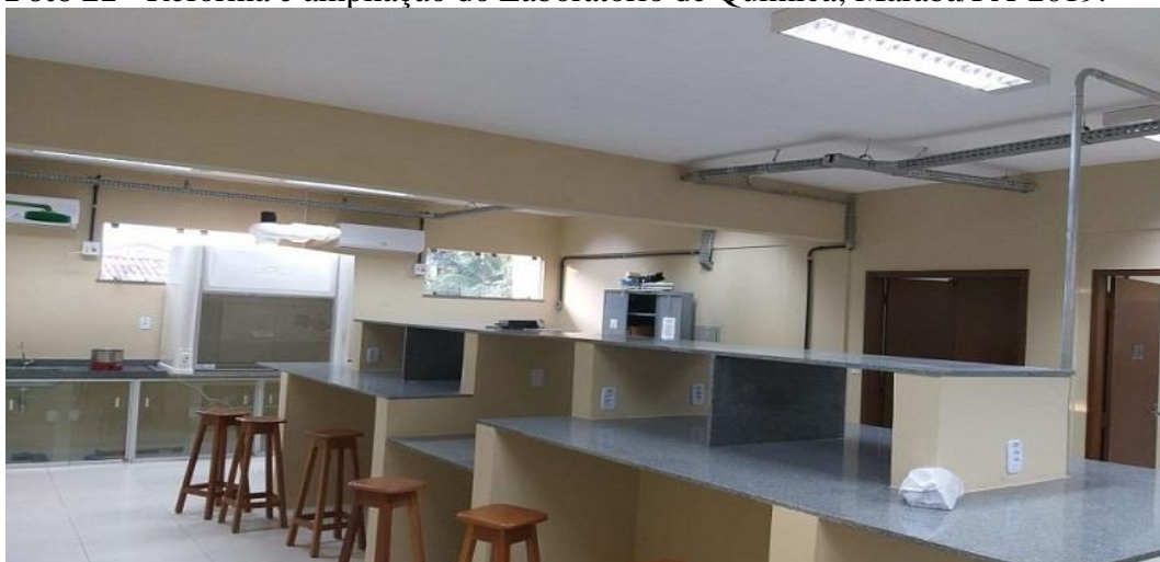
Foto 21 - Reforma e ampliação do Laboratório de Química, Marabá/PA-2019.
