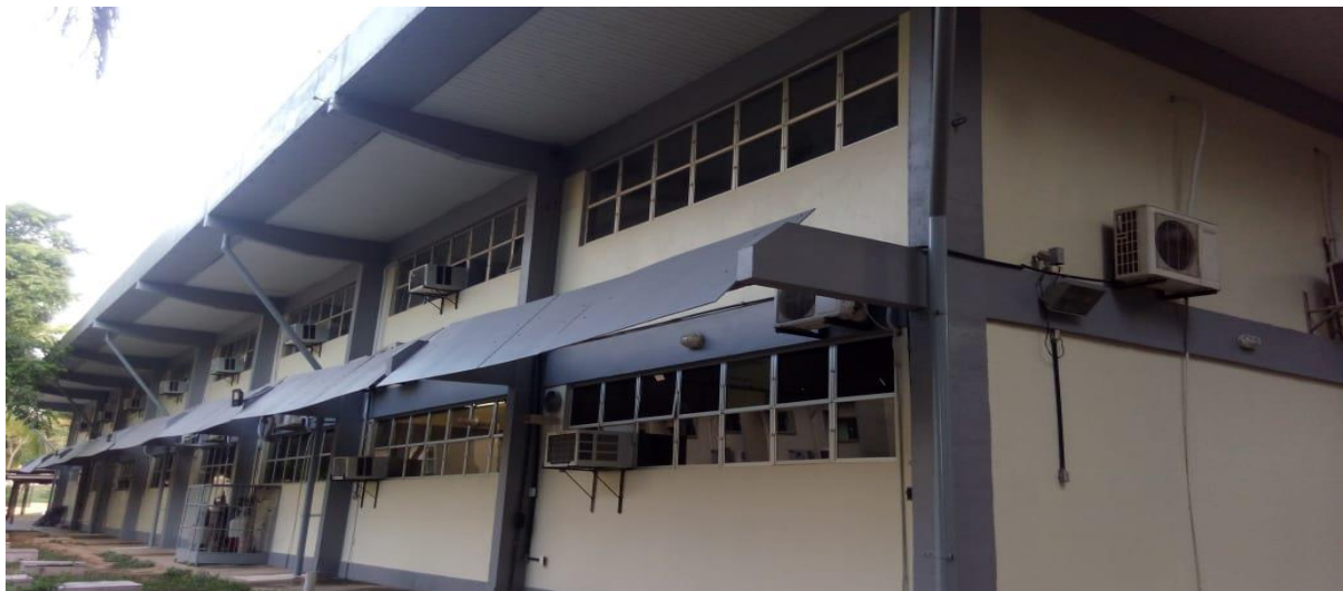
Foto 30 - Revitalização geral do Prédio IV-ICE/IGE na unidade II do Campus de Marabá, 2019.
