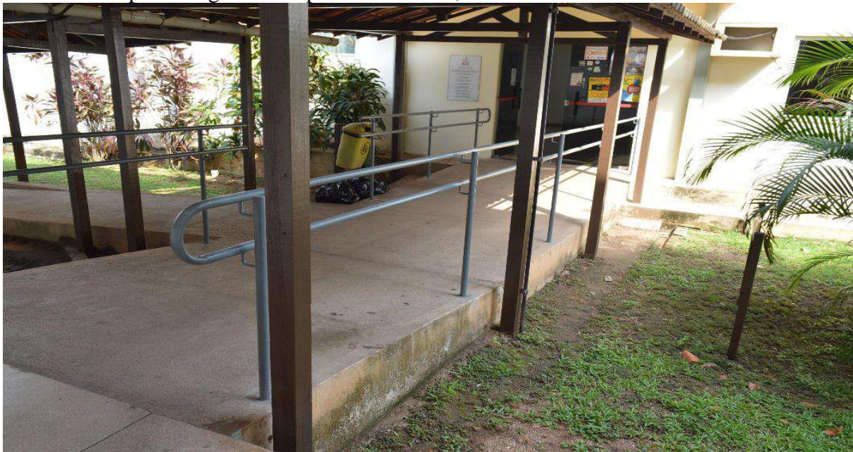
Foto 2 – Rampas com guarda-corpos na unidade I, Marabá-2019.
