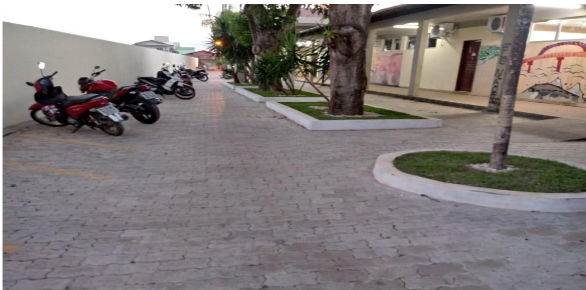
Foto 19 - Reforma e adequação do estacionamento da unidade I, Marabá/PA-2019.
