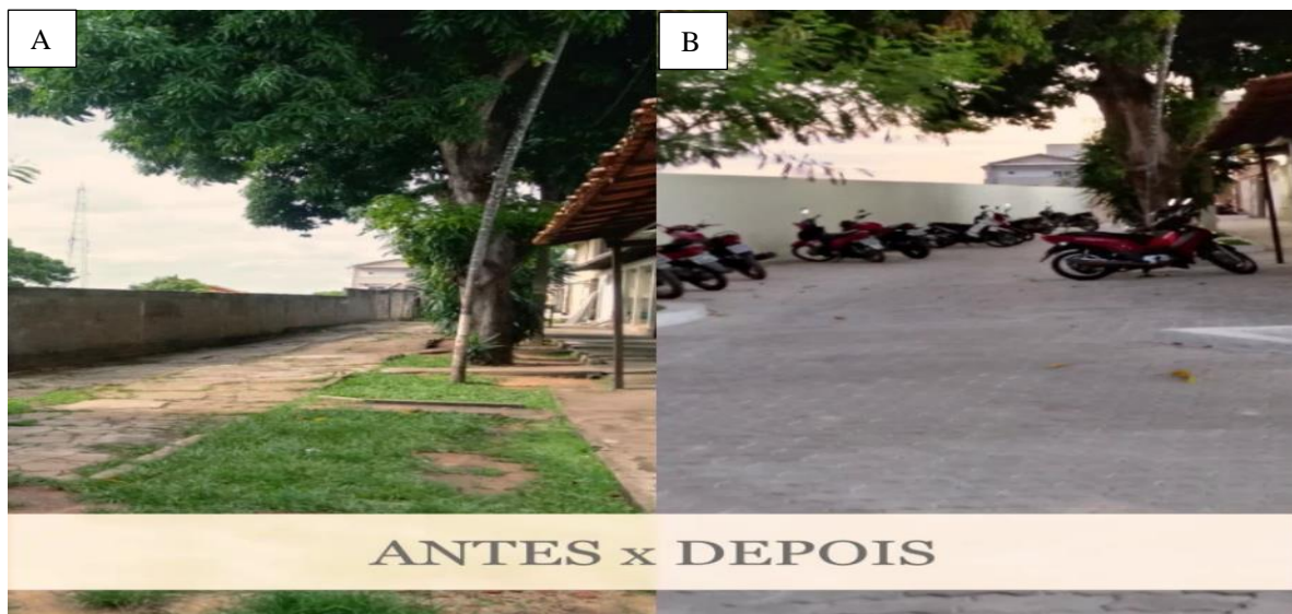
Foto 17 - Reforma e adequação do estacionamento da unidade I, Marabá/PA-2019.
