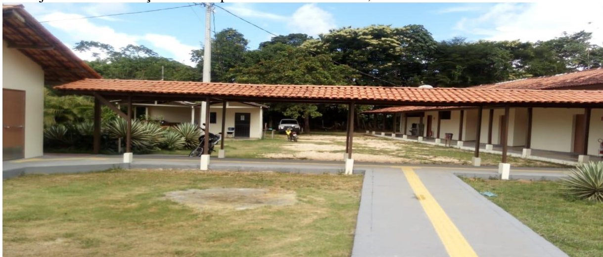
Foto 26 - Adequação e reconstrução do bloco de laboratório de Telejornalismo, Radiojornalismo e Edição no Campus de Rondon do Pará, 2019
