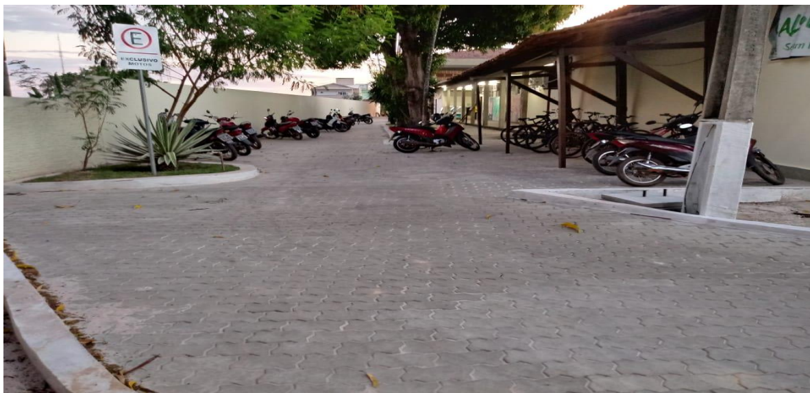
Foto 18 - Reforma e adequação do estacionamento da unidade I, Marabá/PA-2019.
