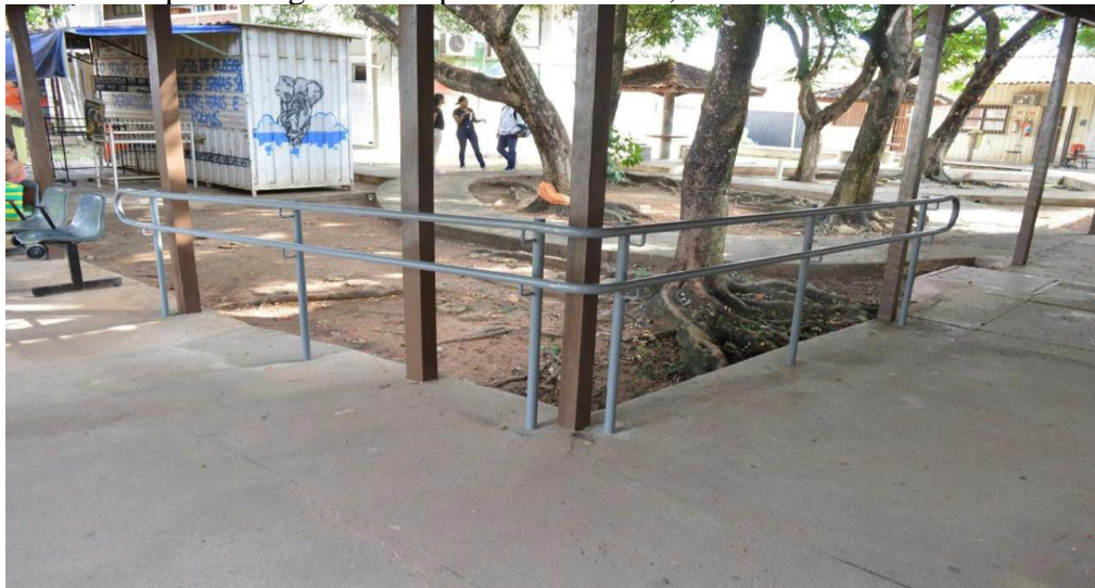
Foto 3 – Rampas com guarda-corpos na unidade I, Marabá-2019.
