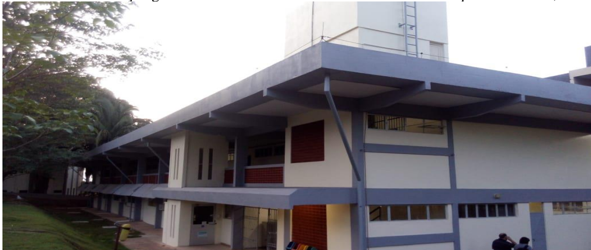
Foto 29 - Revitalização geral do Prédio IV-ICE/IGE na unidade II do Campus de Marabá, 2019.
