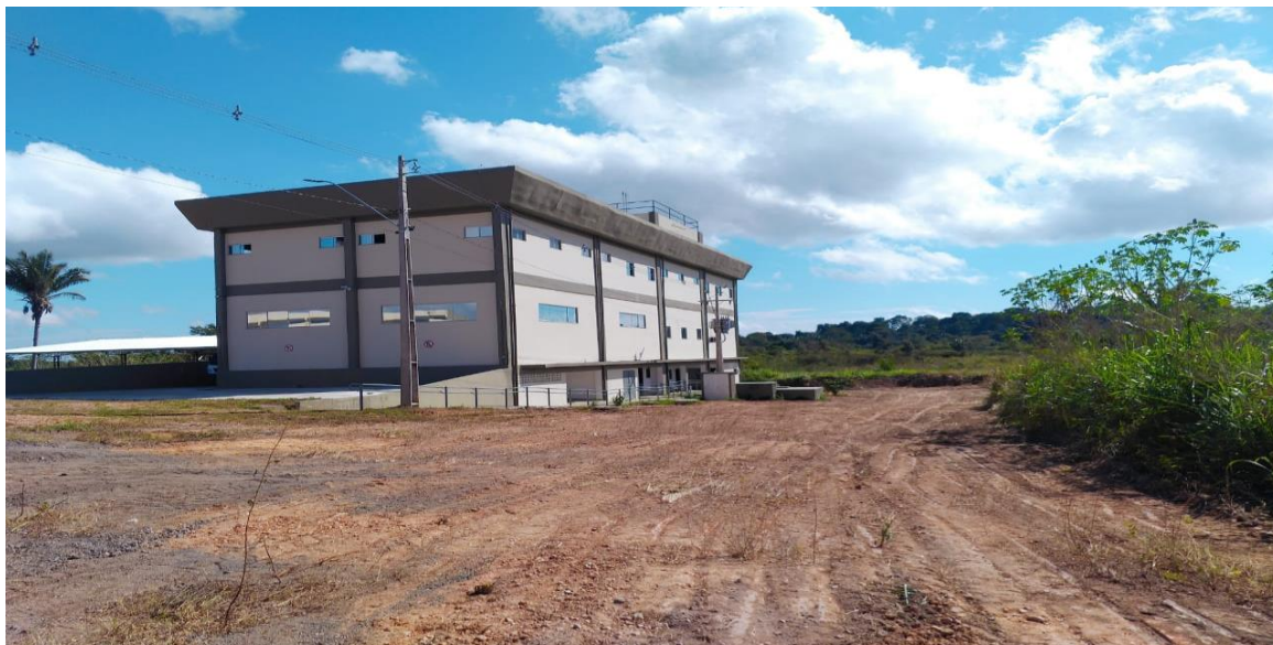
Foto 20 - Limpeza de Terreno da Unidade III, Marabá/PA-2019.
