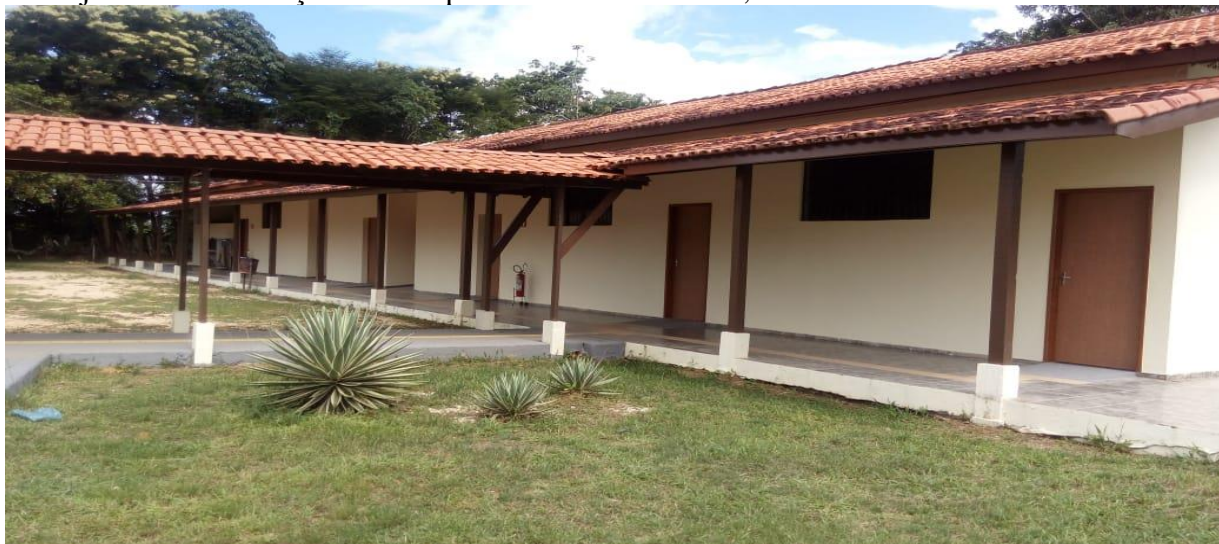
Foto 27 - Adequação e reconstrução do bloco de laboratório de Telejornalismo, Radiojornalismo e Edição no Campus de Rondon do Pará, 2019
