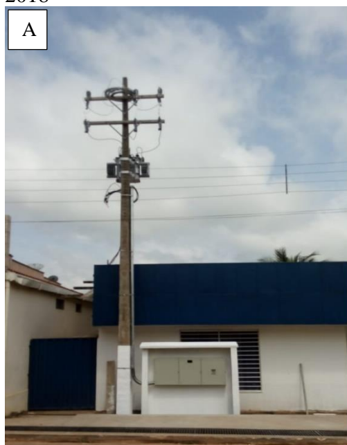
Foto 5 - Instalação da Subestação aérea de 75 kVA na nova Sede do Campus de São Félix do Xingu, 2018
