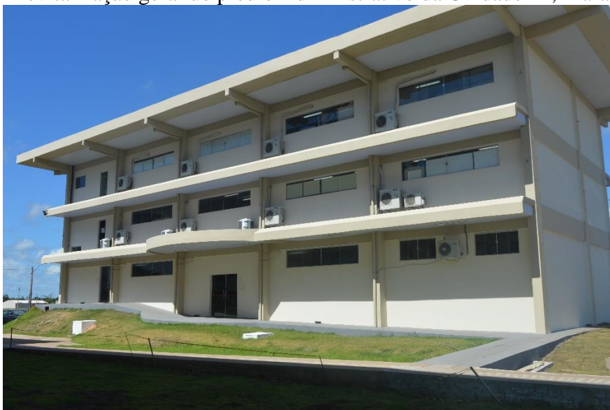
Foto 9 - revitalização geral do prédio Administrativo da Unidade III, Marabá 2018
