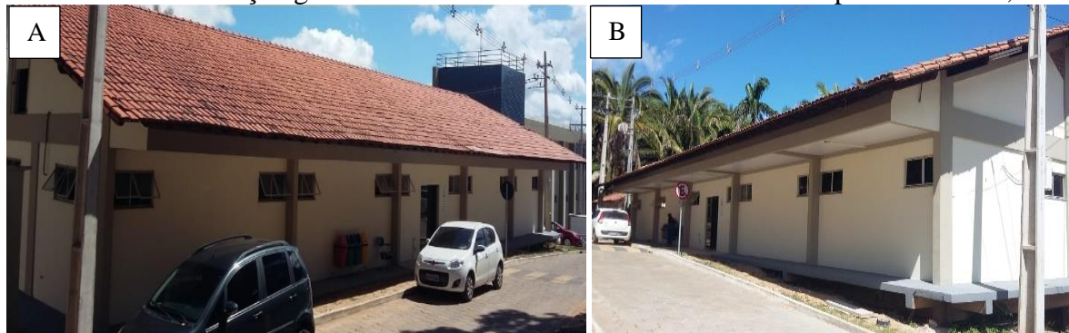
Foto 10 – Revitalização geral do Prédio do CTIC na unidade II do campus de Marabá, 2018
