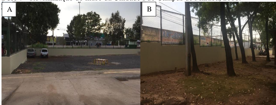
Foto 7 - Revitalização do muro da Unidade I do Campus de Marabá, 2018.
