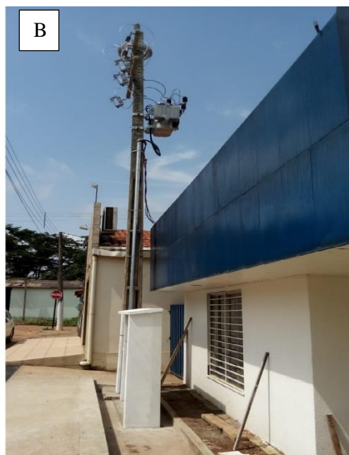
Foto 5 - Instalação da Subestação aérea de 75 kVA na nova Sede do Campus de São Félix do Xingu, 2018
