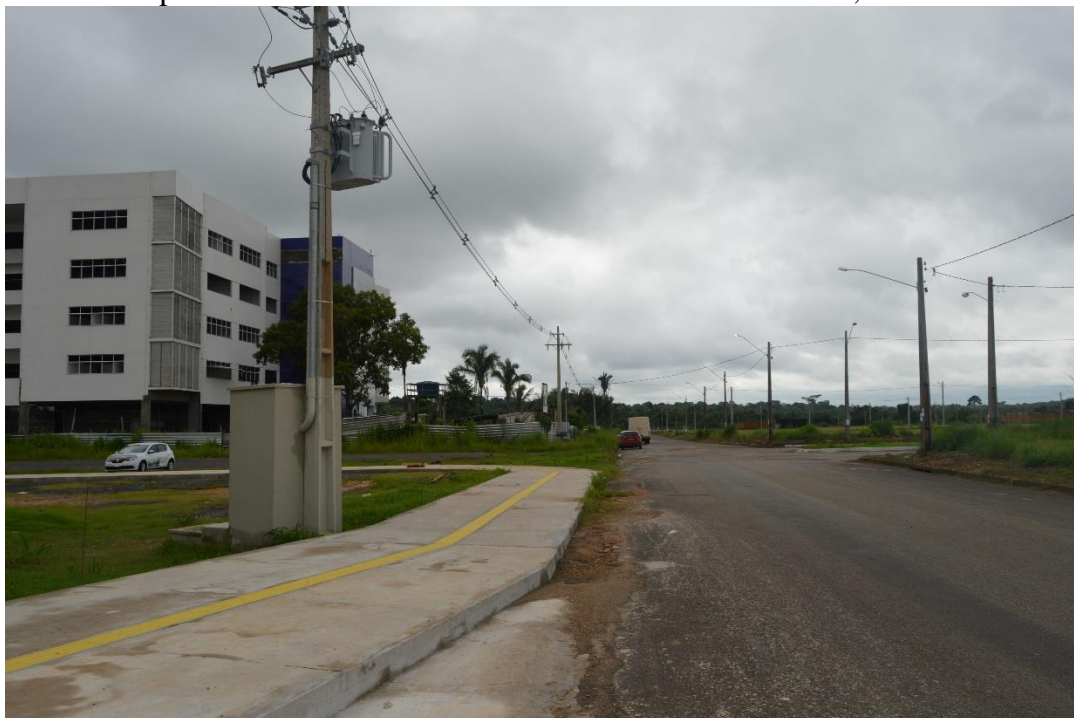
Foto 4 – Expansão da rede elétrica de média tensão na unidade III, Marabá-2018.
