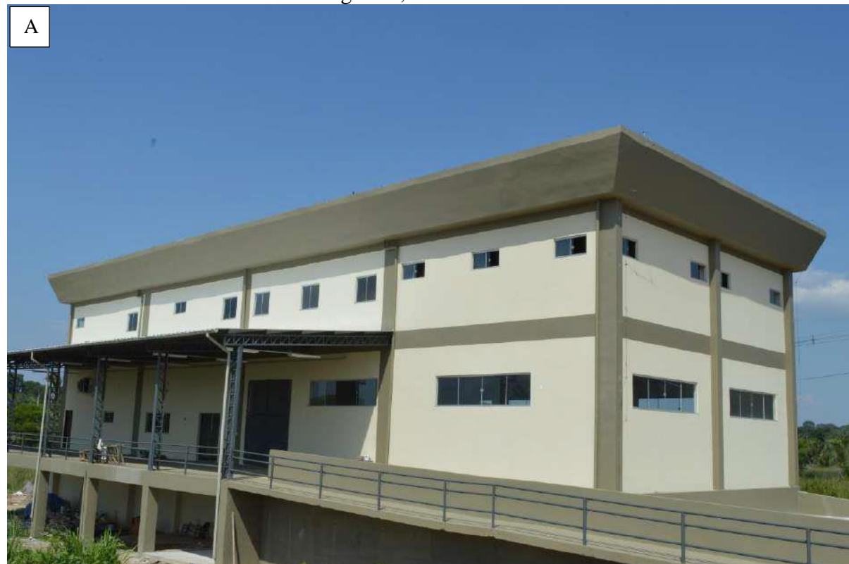
Foto 3- Prédio de Artes Visuais e Logística, Marabá/PA-2018
