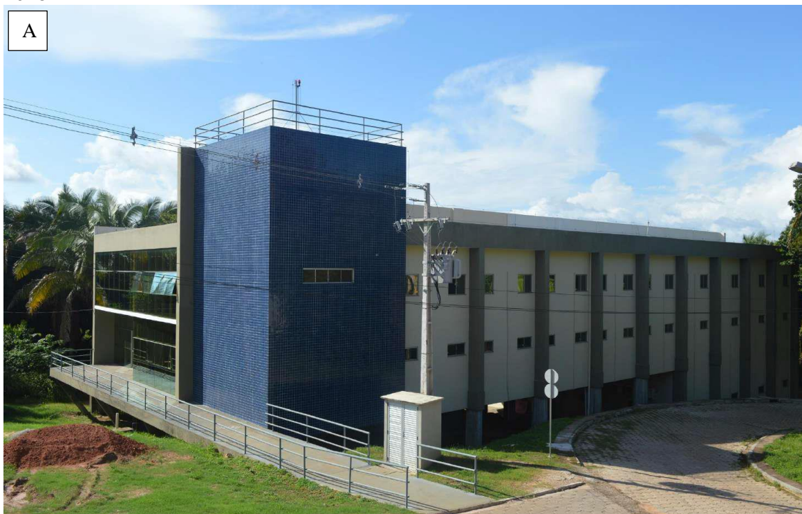
Foto 1- Galpão de laboratórios do Instituto de Geociências e Engenharias (IGE), Marabá/PA-2018
