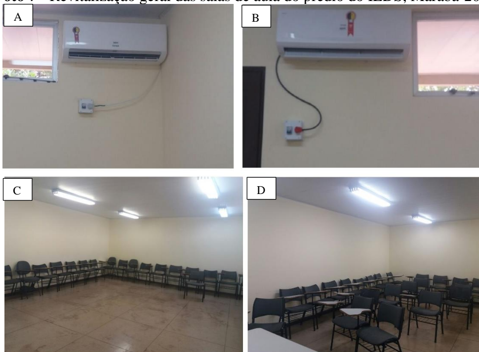
Foto 7 - Revitalização geral das salas de aula do prédio do IEDS, Marabá-2017.
